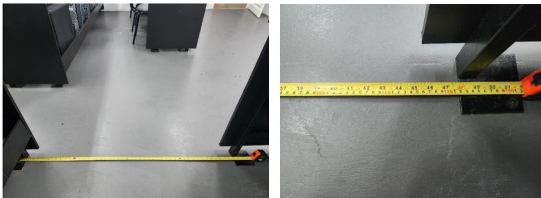
Medidas laterais para entrada ao laboratório de Informática com espaço de acesso com cadeiras de rodas de 130 cm, dentro das normas da NBR que exigem espaçamento entre 90 cm a 1,20 m.
